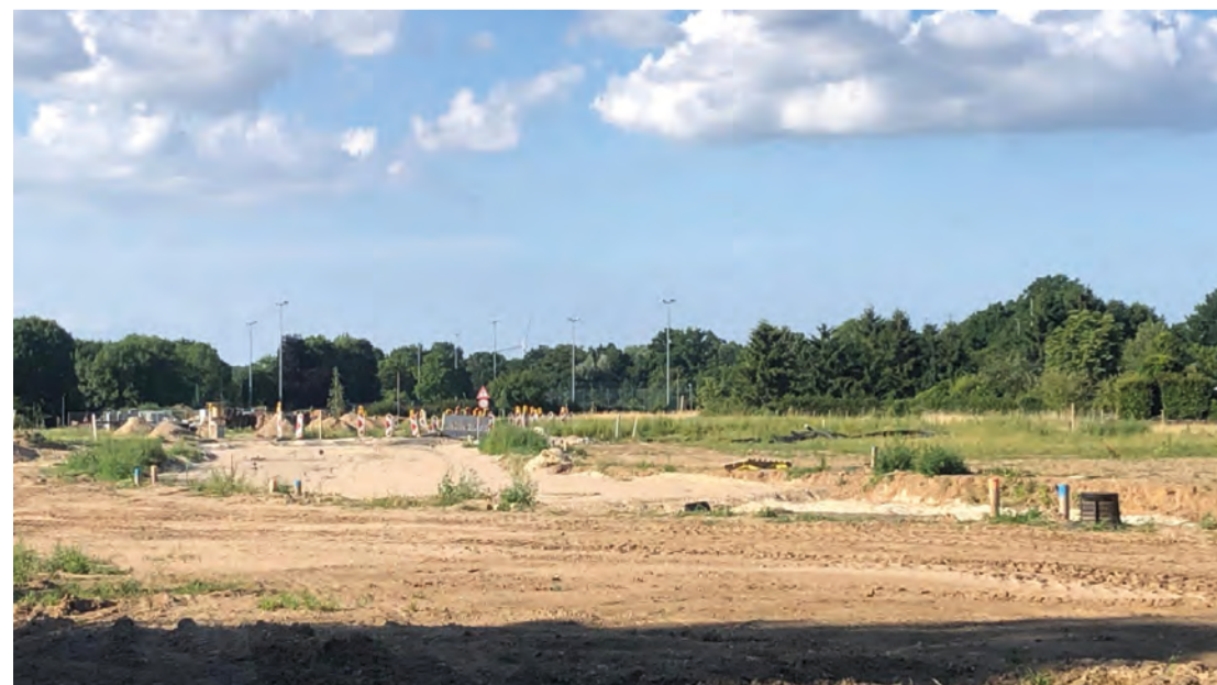
Endlich geht es hier los! Im Lübfeld in Veert fahren derzeit viele Bagger und Baustellenfahrzeuge.
